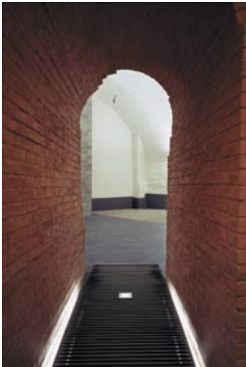
1 Ce couloir revêtu de briques rouges donne accès à l'ascenseur et au local commun. Il a été taillé dans l'ancien mur extérieur du bâtiment.
